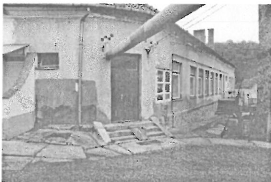
1. sz. kép, az épület bejárati oldala. Az épület déli homlokzata
