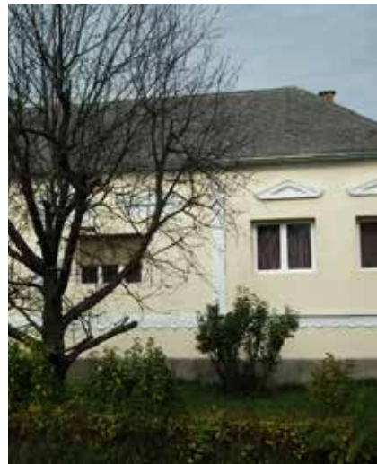
Német u. 2. HRSZ 5051/5 Lakóépület, H-1
