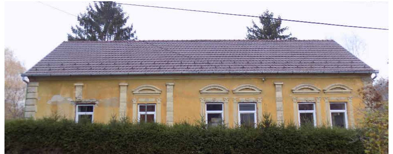
Óvoda u. 12. HRSZ 5347/4 Eklektikus épület, H-1
