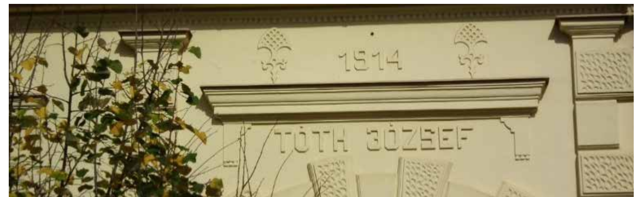
Fábián Béla u. 87. HRSZ 5099 Lakóépület – 1914-ben épült H-1
